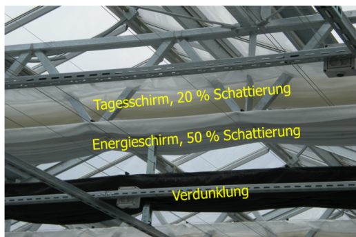
Abb. 2: Konzept zur Wärmedämmung, ZINEG-Haus Hannover mit Isolierverglasung + zwei Energieschirme + Verdunklung
